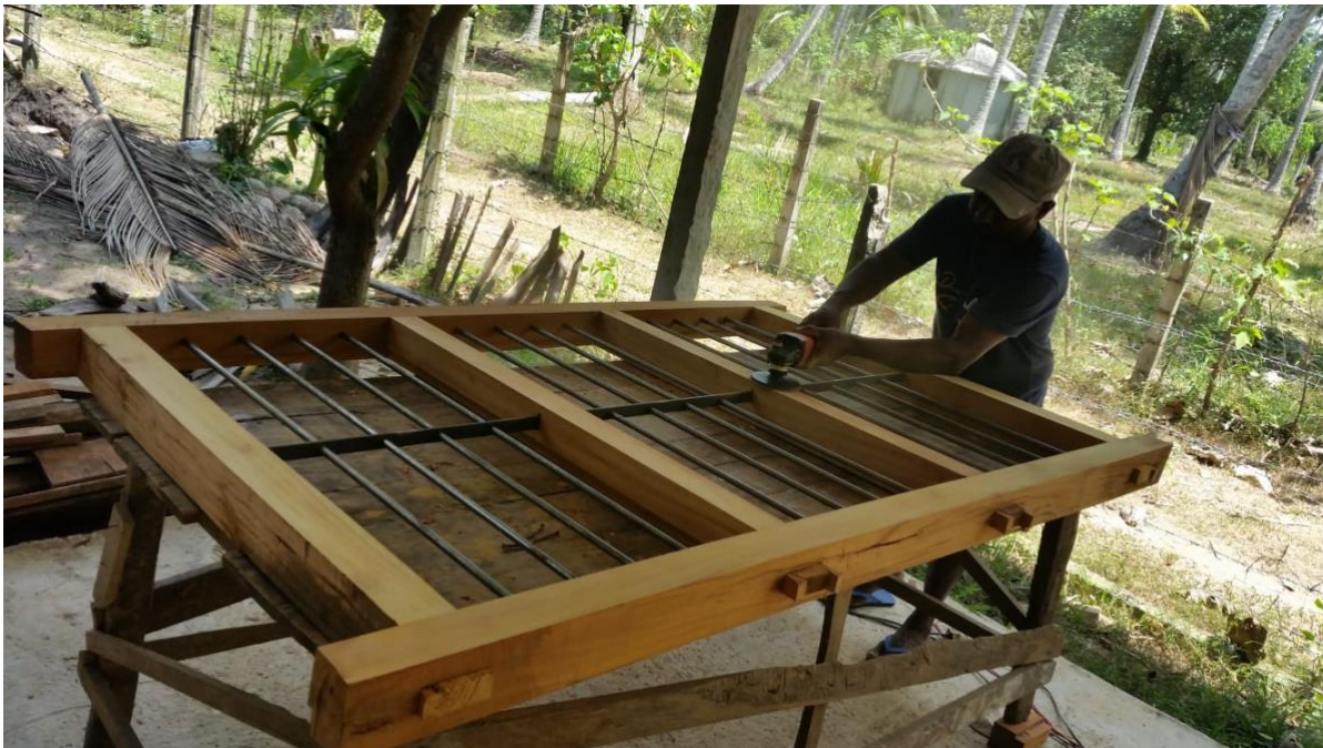
Der Schreiner beim Anfertigen von Türen und Fenster
